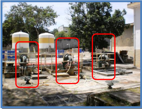
Foto 09: Vista geral dos barriletes.
