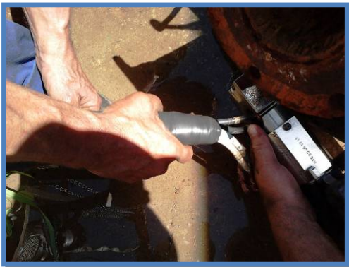
Foto 07: Execução de emenda a compressão.
